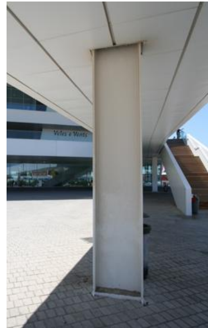
Figura 4.9.- Ejemplo de columna de acero (Pushpullbar, 2007).
